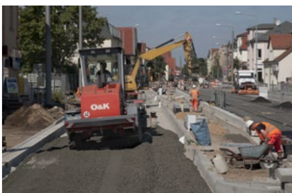
Foto: WOLFF & MÜLLER Tief- und Straßenbau GmbH & Co. KG
