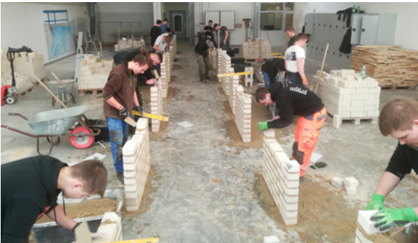
Herstellen einer Mauer
