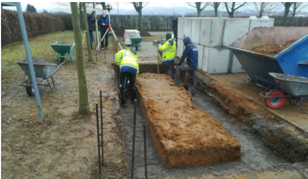
Einmessen eines Streifenfundamentes
