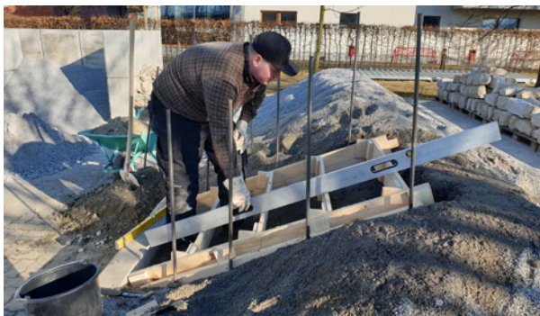
Herstellen einer Böschungstreppe
