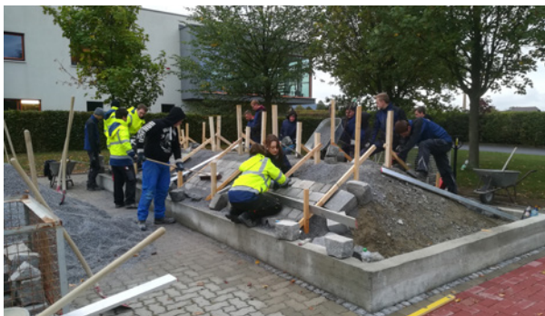
Herstellen von Böschungspflaster
