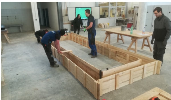
Herstellen einer Fundamentalschalung
