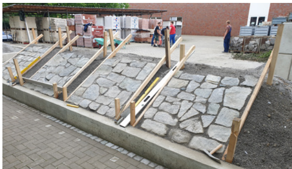
Herstellen von Böschungspflaster
