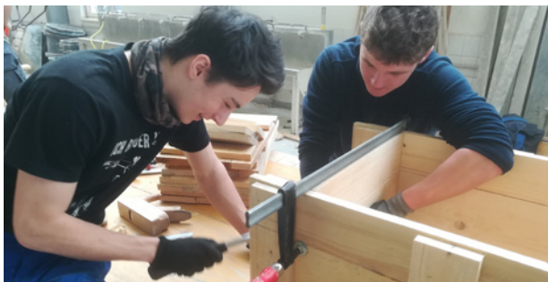
Herstellen einer systemlosen Schalung
