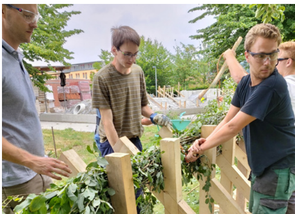
Spreitlage mit Wippe herstellen
